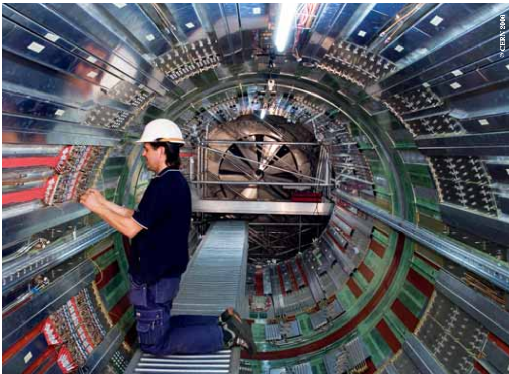
▲ Installation des 40 000 connexions du détecteur CMS.
