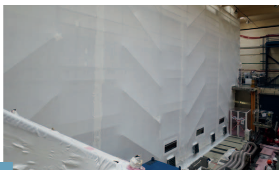
Bâtiment 52-2, la structure est ensuite revêtue d'une toile thermo-rétractable.
