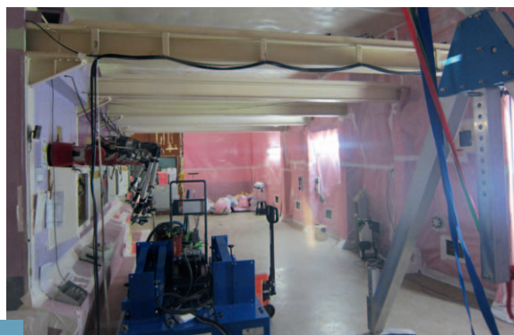
Préparation du sas de confinement de l'enceinte Candide, préalable à son démantèlement.
