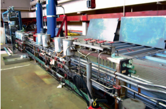
L'événement du 21 février 2013 s'est déroulé sur ce chantier de démontage de dispositif de la chaîne Pétrus. © CEA
